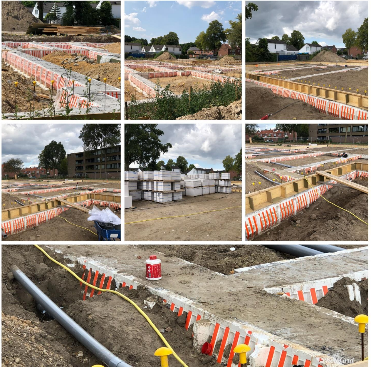
Juli / augustus 2018 fundering en grondwerk zoals afvoerleidingen. De bodemplaten en gasbetonblokken voor de muren liggen klaar.
