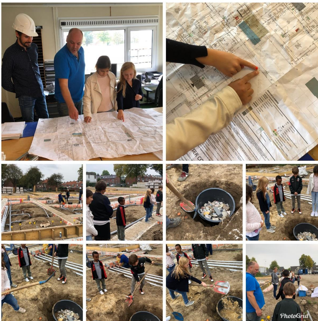
3 september 2018: EEN MIJLPAAL!! Alle geluksstenen van de kinderen van onze school zijn in de fundering ingegraven.
