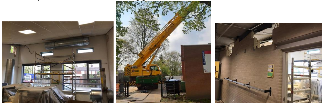
Tijdens de werkzaamheden
