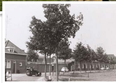
Groenewoudstraat omstreeks 1972 (nu Kaukasuslaan). Net voor de nieuwbouw start. Foto: Lambach/Gemeente Tilburg, Collectie Regionaal Archief Tilburg
