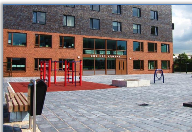
Locatie West Bovenbouw, Grahamstraat
