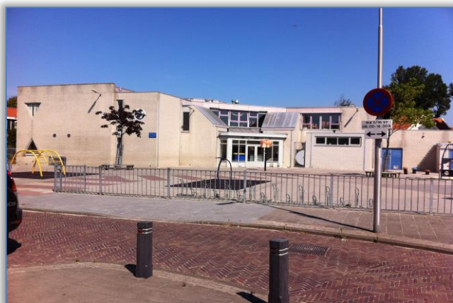
Locatie West Onderbouw, Stephensonstraat
