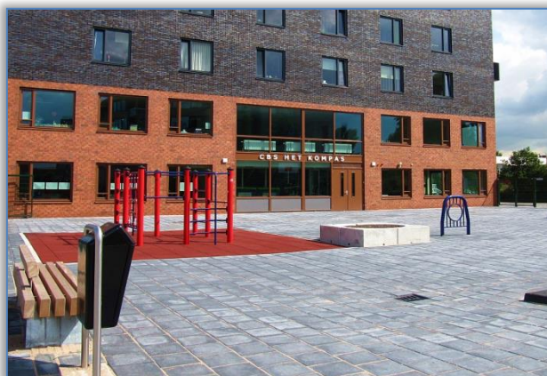
Locatie West Bovenbouw, Grahamstraat
