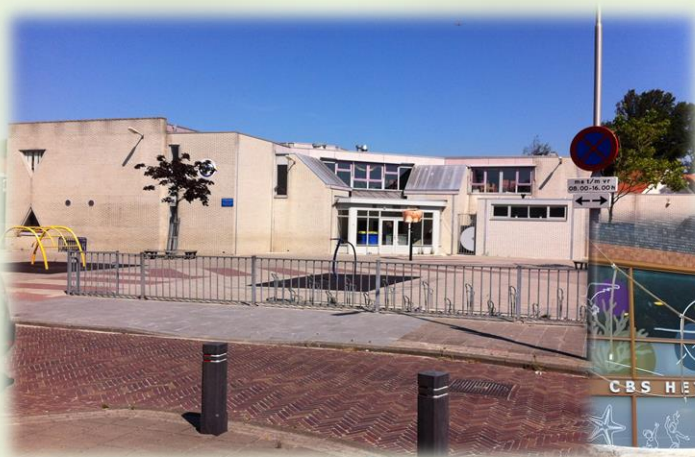
Locatie West Onderbouw, Stephensonstraat
