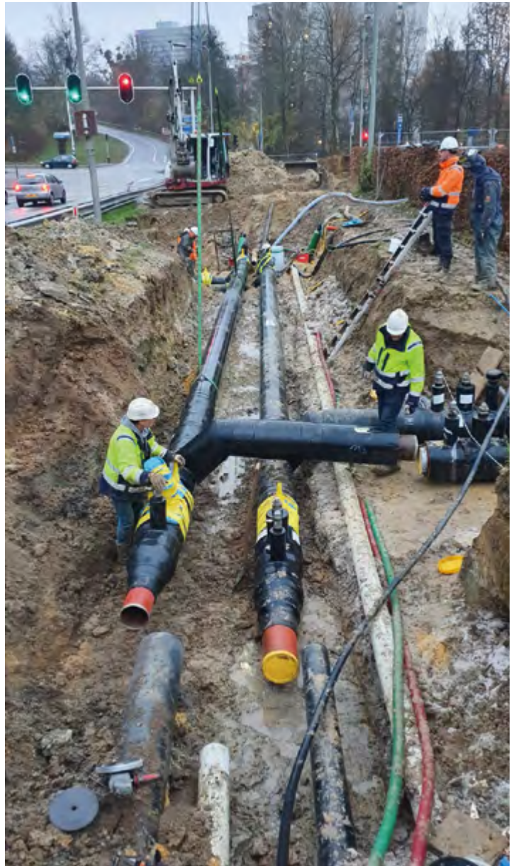
Werken aan het hoofdleidingnet van Mijnwater. (Foto Mijnwater B.V.)
